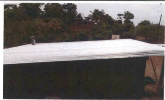
Foto 2: Trabajos realizados en la cocina finalizados..
