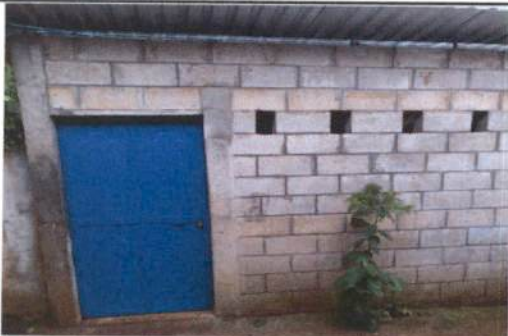
Foto 3: Instalación de puerta y cambio de estructura de madera por metal en cocina.
