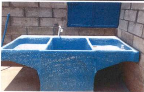
Foto 5: Pila nueva instalada en la cocina.
