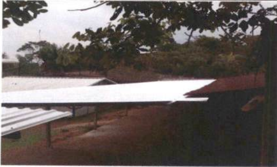
Foto 1: Sustrucción de estructura de madera por metal en corredor y cocina.
