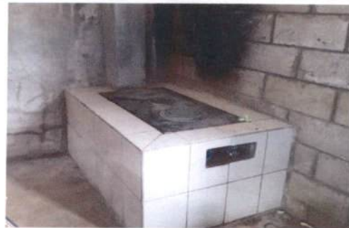
Foto 4: Estufa completa construida en cocina..
