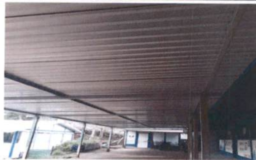
Foto 6: Techo y estructura del corredor finalizado.
